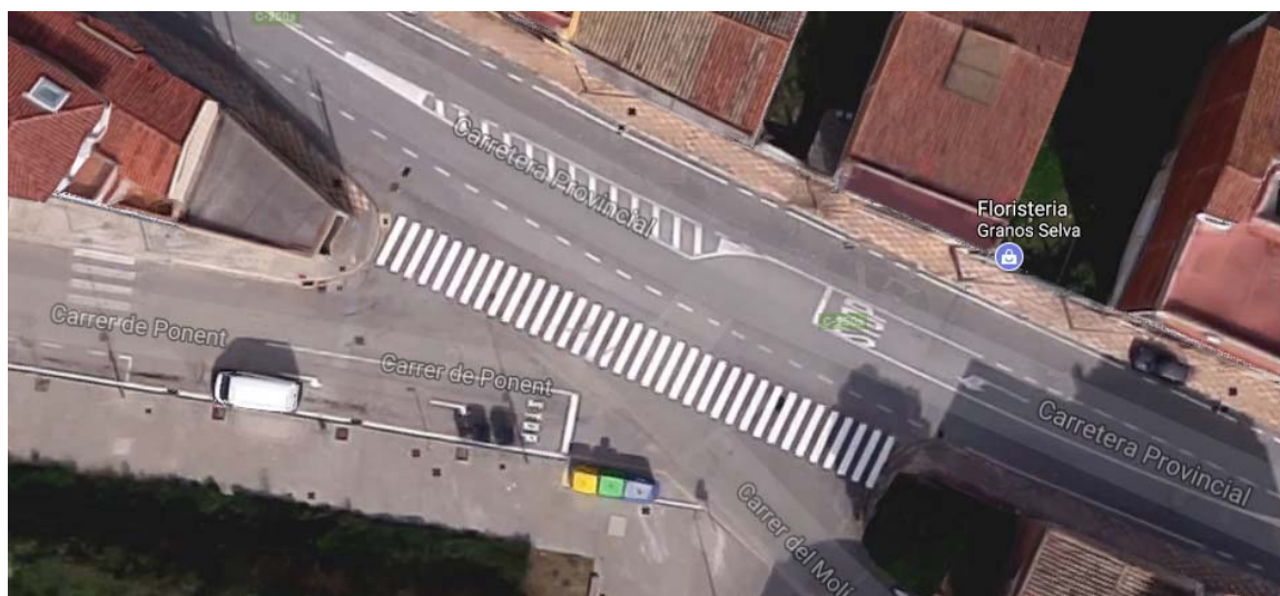
Fotografia 3.1.3.5 – exemple de pas de vianants massa llarg. Font: Google
