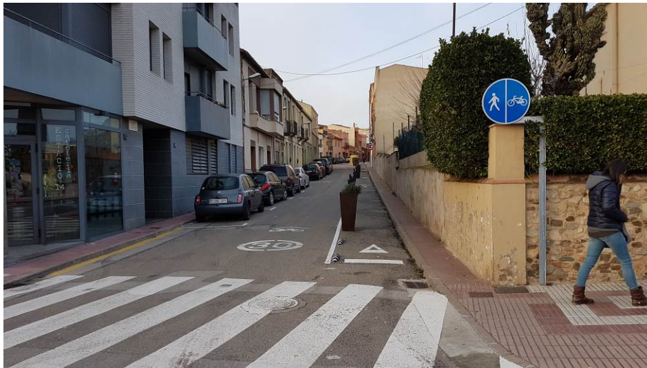
Fotografia 4.4.1.1 - Inici de carrer 30 amb carril bici-vianant en sentit contrari
