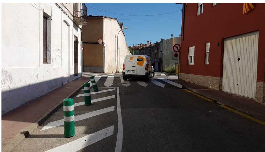
Fotografia 3.1.2.2 - Exemple de cruïlla amb pas elevat i elements per millorar-ne la visibilitat
