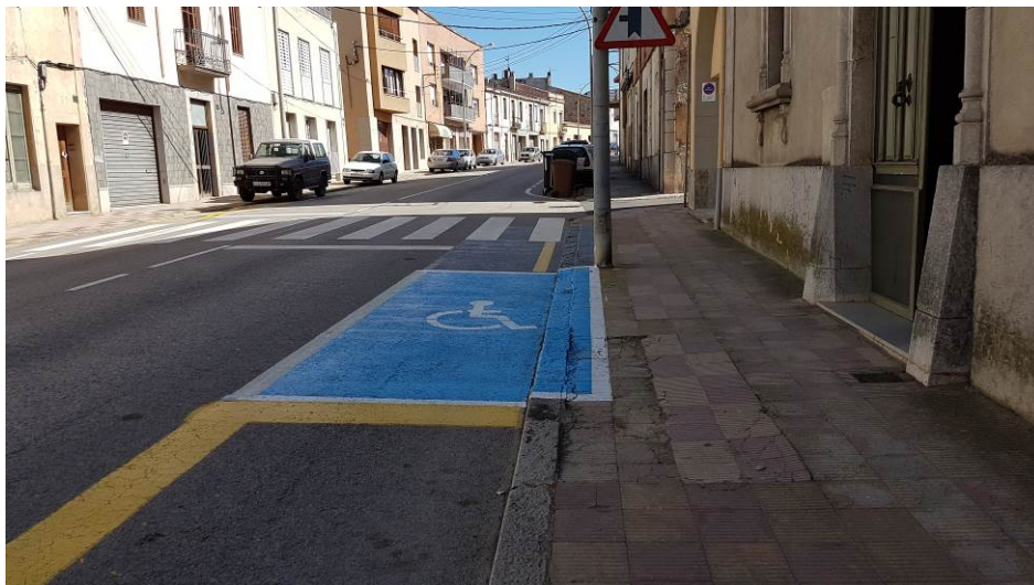
Fotografia 3.1.3.4 – Aparcament permès entre la calçada i la vorera.
