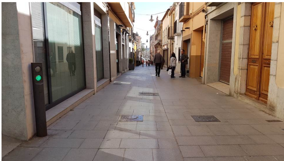
Fotografia 3.1.1.2 - Exemple de carrer de plataforma única
