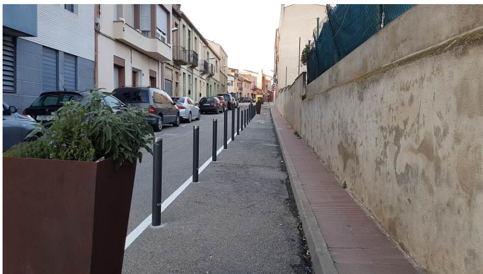
Fotografia 4.4.1.2 – Solució de calçada amb sobreample
