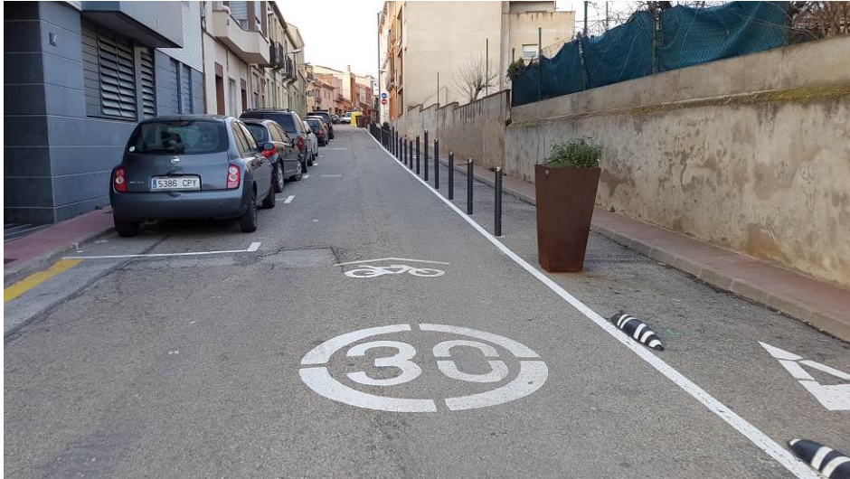
Fotografia 3.1.1.4 - Exemple vorera ampliada a la calçada
