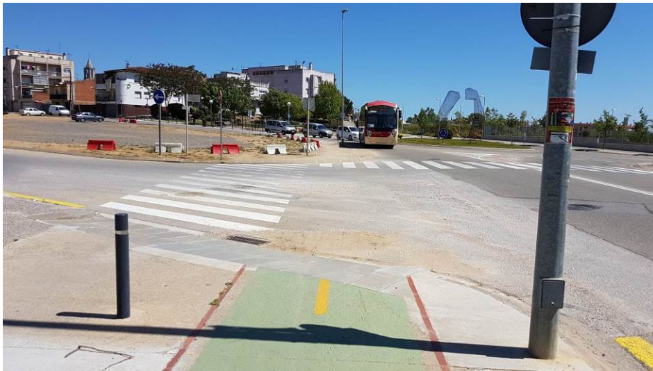
Fotografia 4.4.2.1 – Exemple de manca de senyalització vertical
