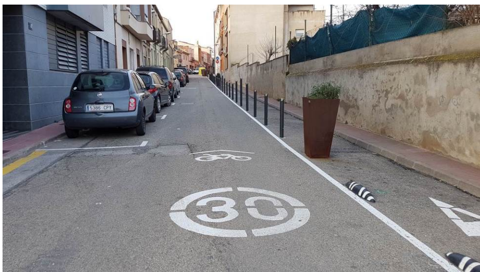
Fotografia 4.1.6.2 - Exemple de carrer 30 amb logos de bicicleta per reforçar el missatge de carrer compartit
