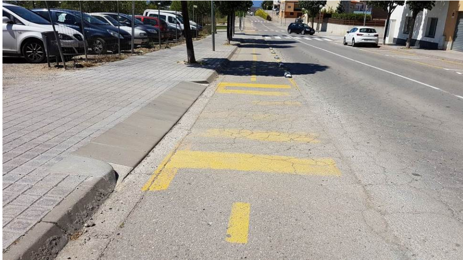
Fotografia 4.4.2.5 – Exemple de senyalització incorrecta
