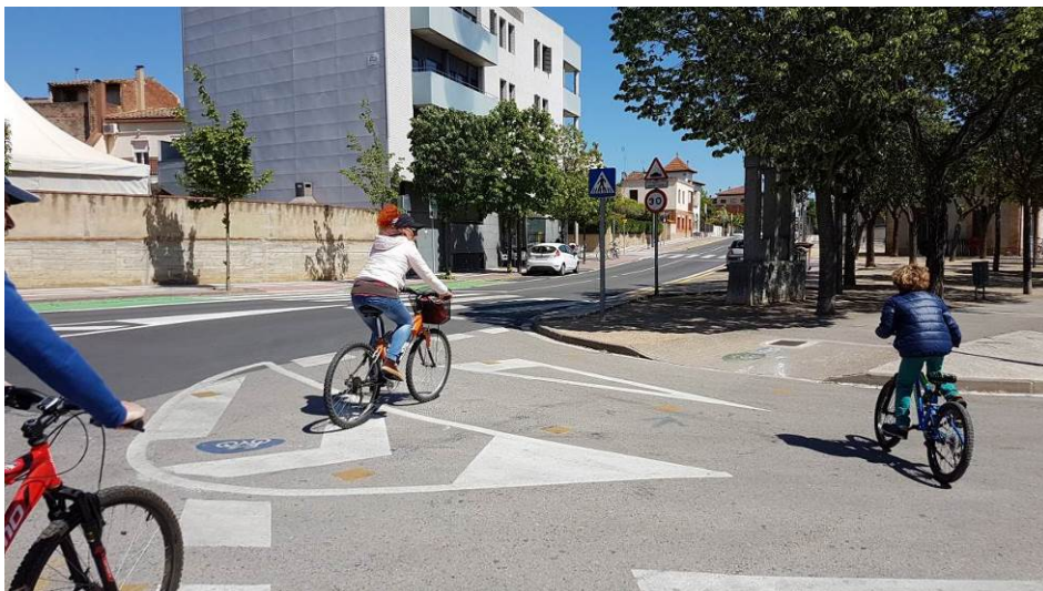
Fotografia 4.4.2.4 – Manca de pintura delimitadora de l'espai ciclista
