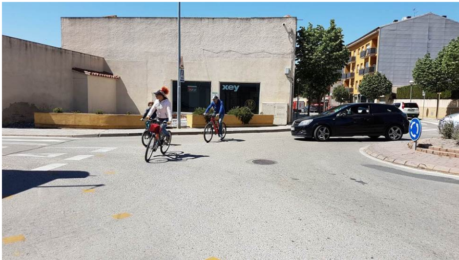
Fotografia 4.4.2.3 – Manca de pintura delimitadora de l'espai ciclista
