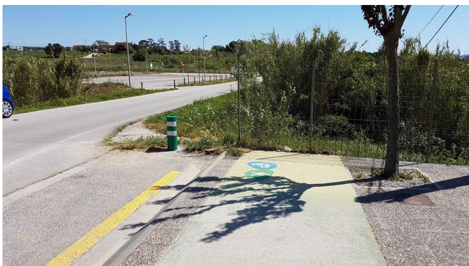
Fotografia 4.4.2.14 – Final sense continuïtat de l'itinerari ciclista
