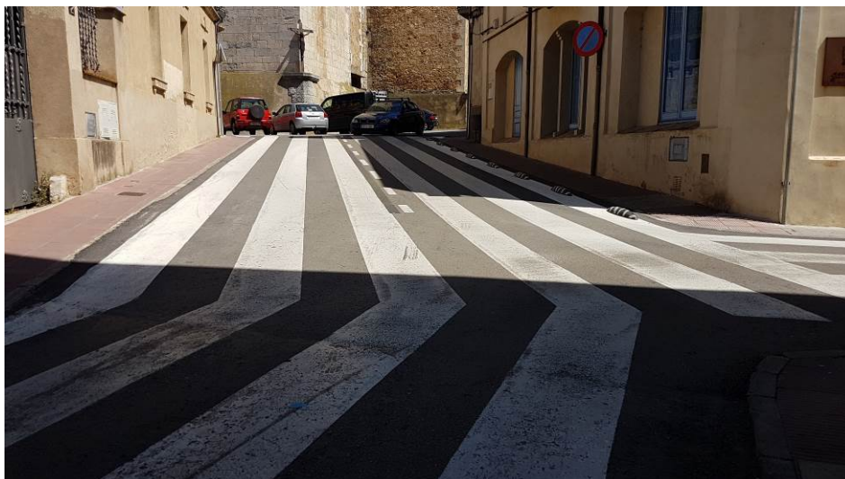
Fotografia 3.1.3.1 - Exemple de pas amb mala visibilitat
